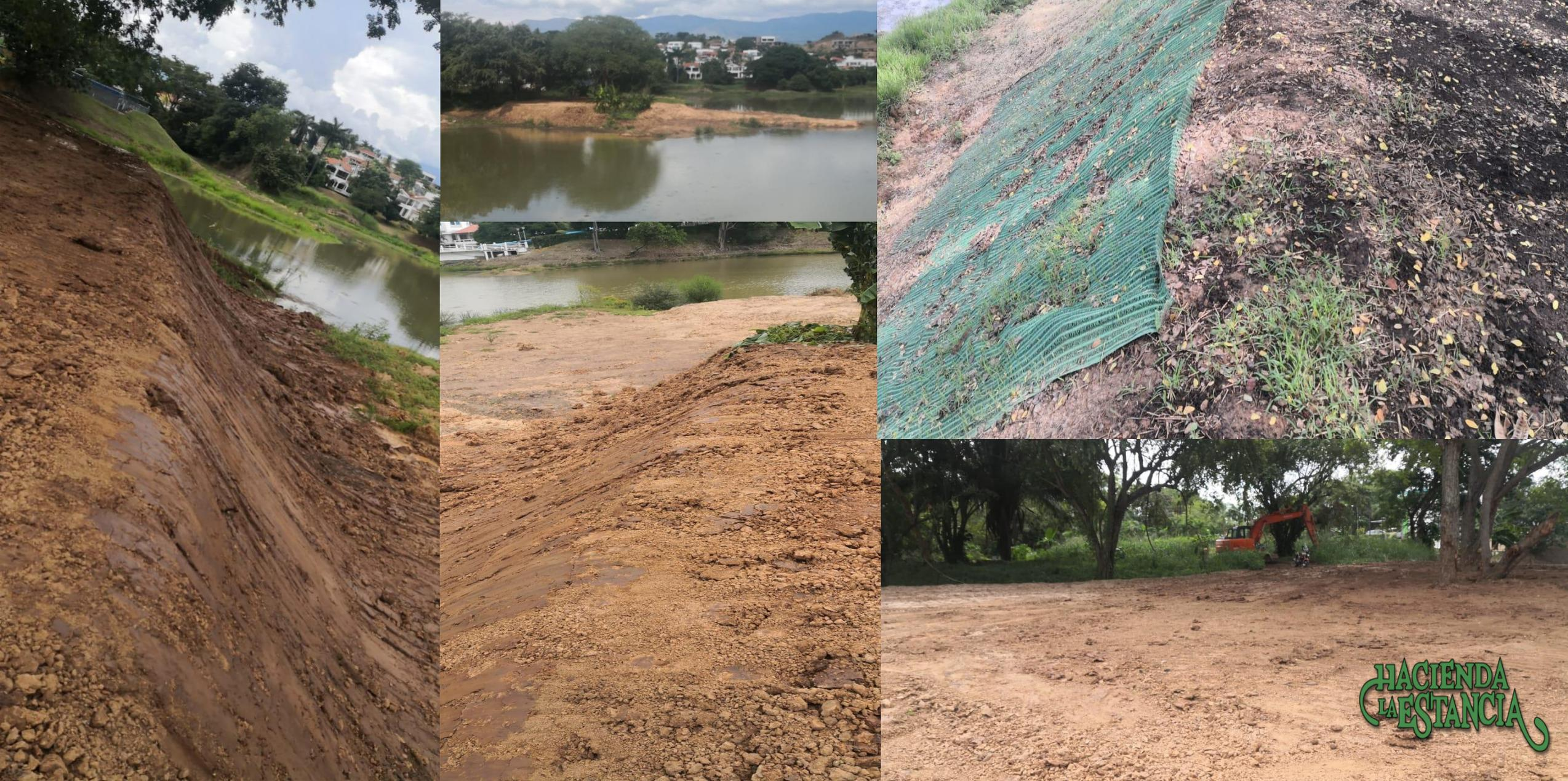
Dragado del lago con confirmación de talud
