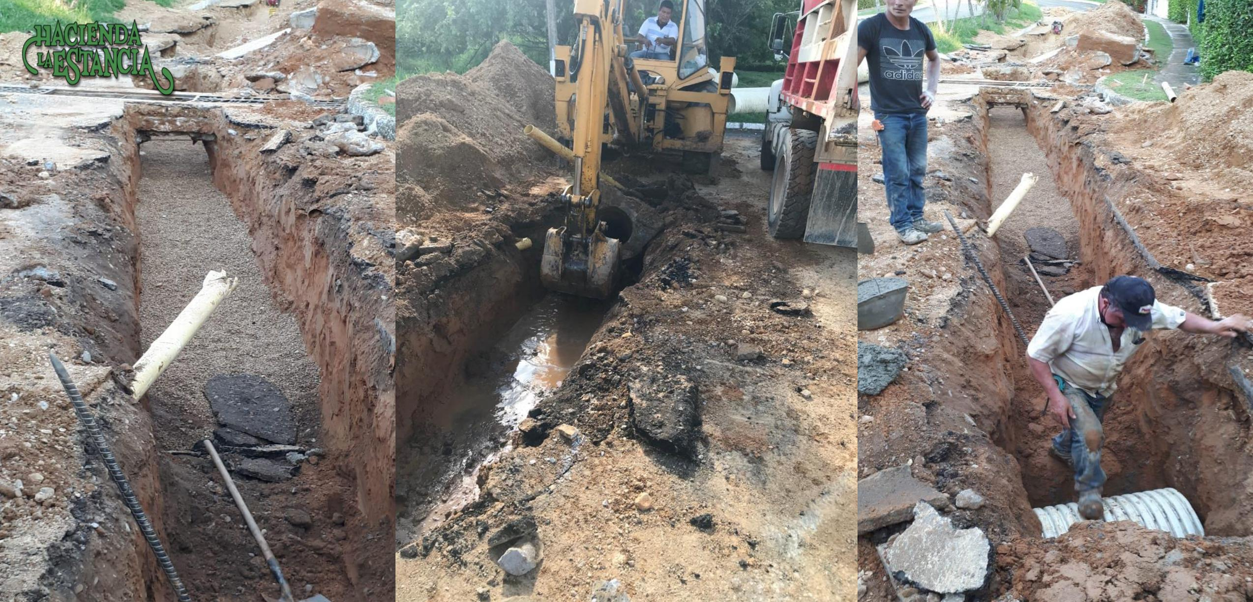
Cambio de tubería que colapsó por el tiempo de uso la cual se reemplazó por tubería novafor y se amplió el diámetro a 24" - obra en ejecución (\*Pendiente la pavimentación)
